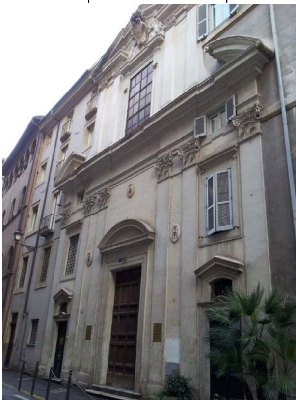
Foto 12 – facciata dopo l'intervento di estirpazione delle foglie
