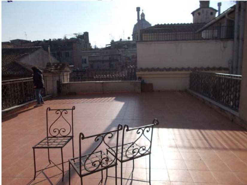
Foto 3_Copertura della volta
