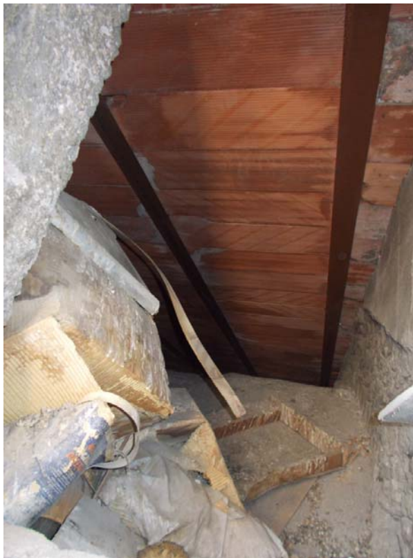
Foto 13 – Estradosso della volta ed intradosso della terrazza di copertura
